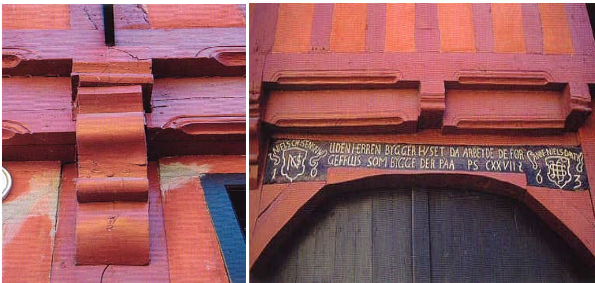
Bygherren har på portliggeren mellem sit og hustruens bomærker ladet skære et citat fra Davids 127. salme, vers 1: "Hvis ikke Herren bygger huset, arbejder håndværkeren forgæves." Mogens Mølle Nielsen Fot.
